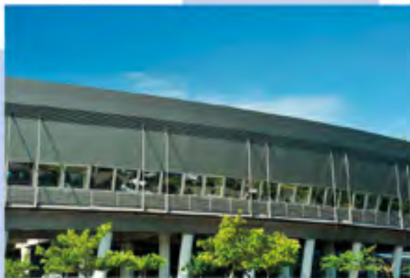
Le bloc opératoire, composé de 11 salles d'intervention
