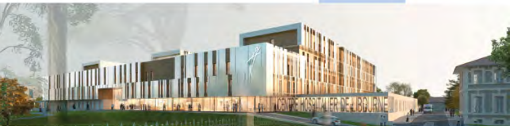
Le bâtiment neuf de 43 000 m2, au coeur du projet de restructuration du Centre Hospitalier dont la mise en service est prévue début 2018.
