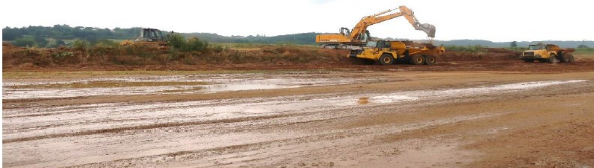
Figure 7 : Opération de décapage (source : ARTIFEX 2020)
