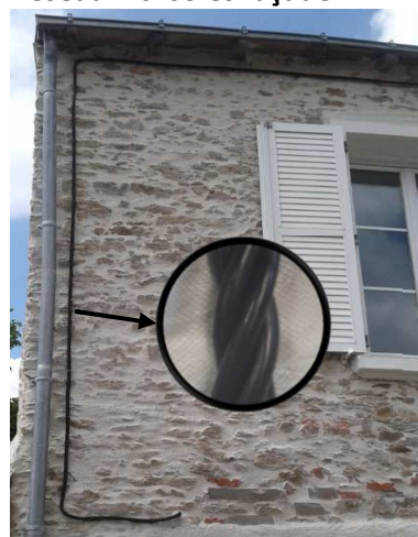
Réseau fils isolés façade BT
