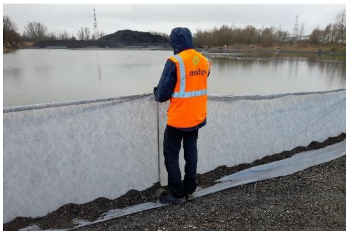
Pose d'une bâche anti-amphibiens sur un chantier
