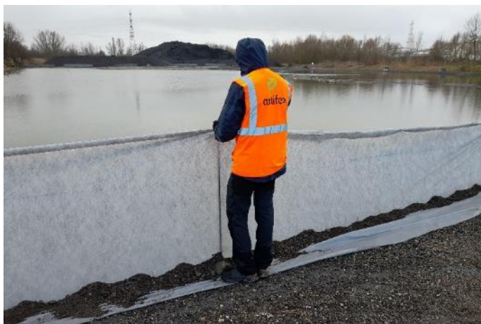
Pose d'une bâche anti-amphibiens sur un chantier
