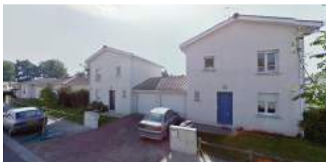
Avenue Georges Brassens à Saint-Denis de Pile
