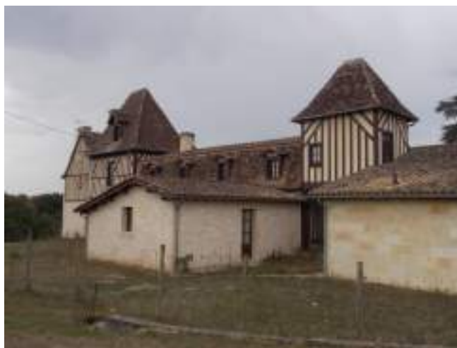
L'exemple de construction agricole mixte pierre – bois – Saint Antoine sur l'Isle
