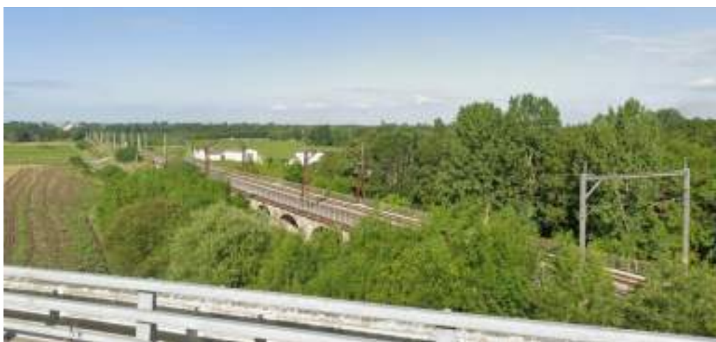
Vue de la voie ferrée Bordeaux-Libourne depuis le viaduc de l'A89
