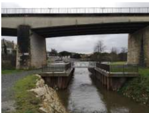
Figure 39 : Vue sur le début de la rivière de contournement en aval
