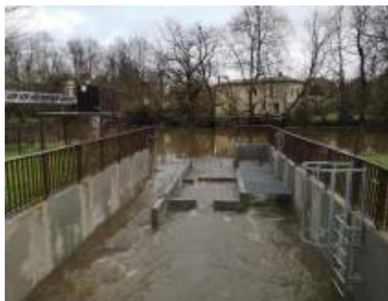
Figure 40 : Vue sur la rivière de contournement en amont
