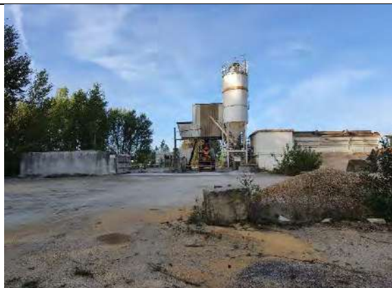
Site industriel et zone imperméabilisée
