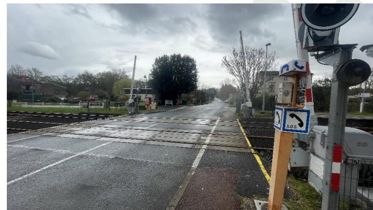
Exemple de marquage de continuité piétonne – St-Seurin sur l'Isle
