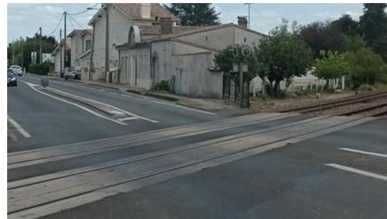
Exemple de non-marquage de continuité piétonne – St-Médard de Guzières
