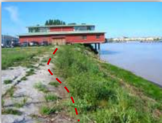
Revégétalisation artificielle en partie supérieure sur géotextile biodégradable (à gauche) et spontanée en partie inférieure sur géogrille anti-érosion (à droite), sur les digues en rive droite de Bordeaux (EC/CBNSA, août 2018). Moins de six mois après l'achèvement des travaux, on constate une très bonne reprise spontanée de la végétation sur la partie inférieure (non revégétalisée artificiellement), en particulier l'expression d'espèces caractéristiques des berges estuariennes.
